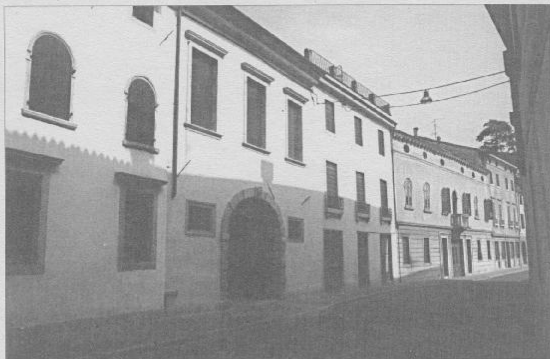
Istituto Cesana Malanotti - Vittorio Veneto. Piano di recupero per la costruzione di 23 mini alloggi per anziani. Particolare del fabbricato attuale.
